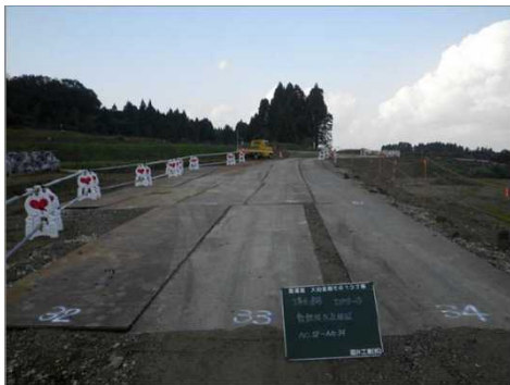
工事用道路 敷鉄板
