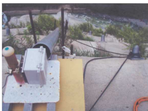
伸縮計設置状況
