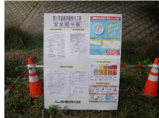
【 熱中症対策掲示板の設置 】
