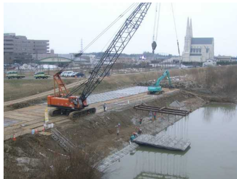
【低水護岸工】大型連節ブロック吊落し
