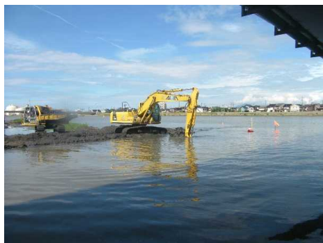
【河道掘削】掘削・土砂運搬
