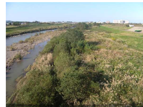
【高水敷整正工】伐木・集積運搬
