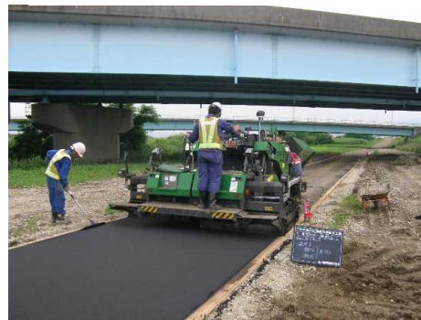
【管理用通路舗装工】アスファルト舗装
