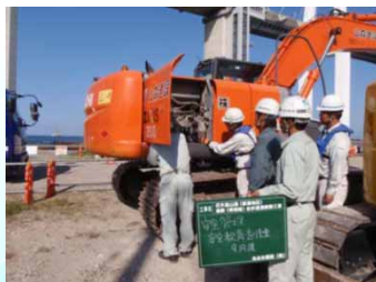
バックホウ点検実施
