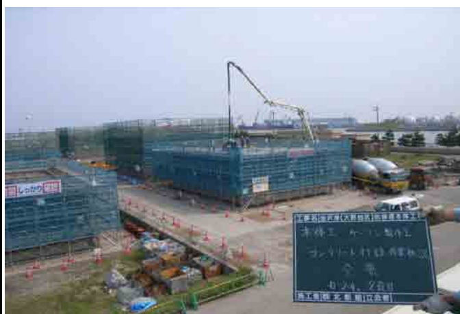
コンクリート打設状況
