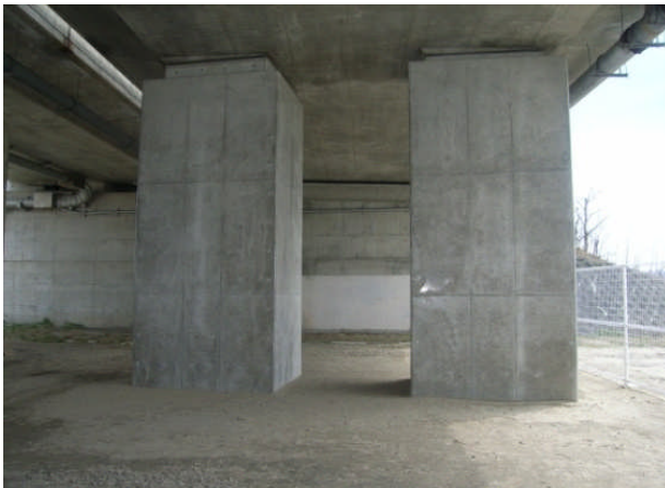
三賀橋(RC橋脚巻立て)
