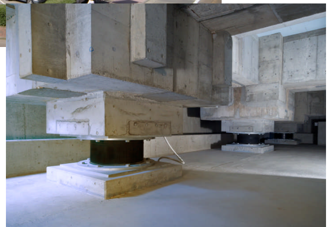
地下免震支承部状況
