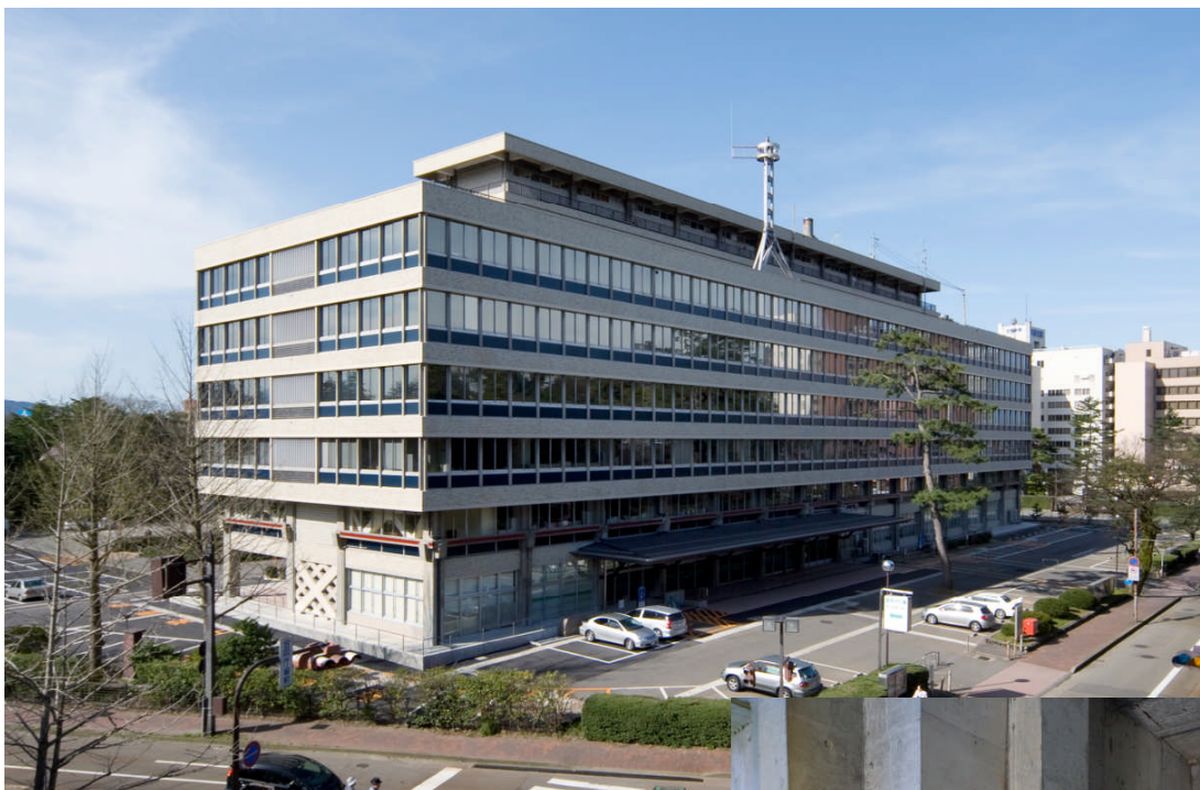
合同庁舎全景
