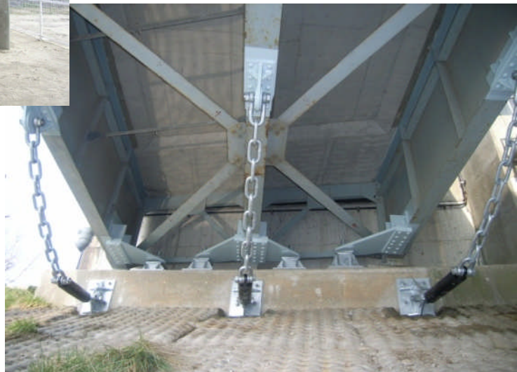
三賀橋(変位制限装置、落橋防止装置)
