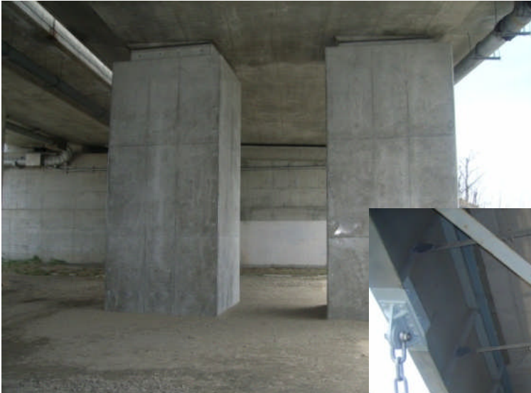
三賀橋(RC橋脚巻立て)
