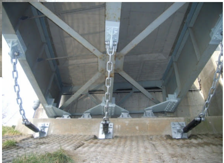
三賀橋(変位制限装置、落橋防止装置)
