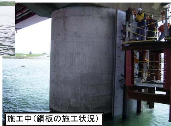
施工中(鋼板の施工状況)
