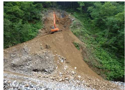
ロングアームバックホウによる掘削
