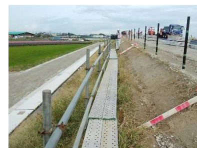
【防草コンクリート簡易足場設置】
