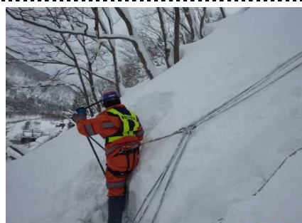
のり面ロープ高所作業
