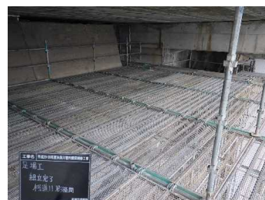
足場内部状況
