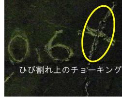
写真2 チョーキング状況
