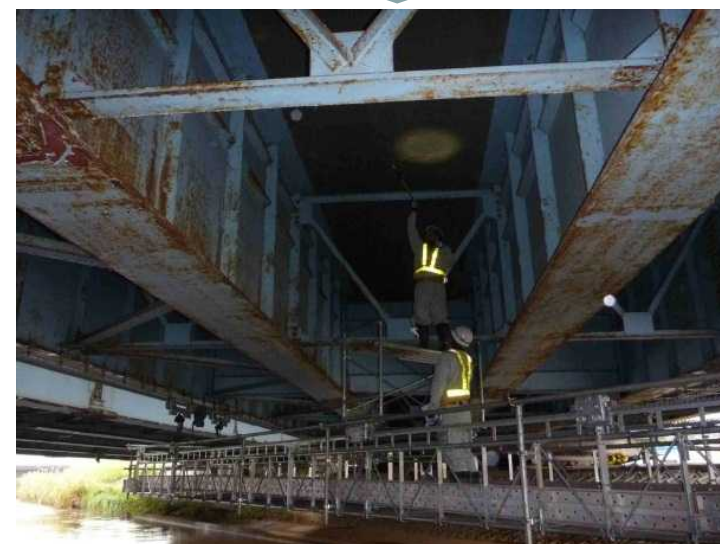
移動式足場による点検
