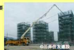
中詰めコン打設
