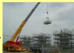
クレーンで設置
