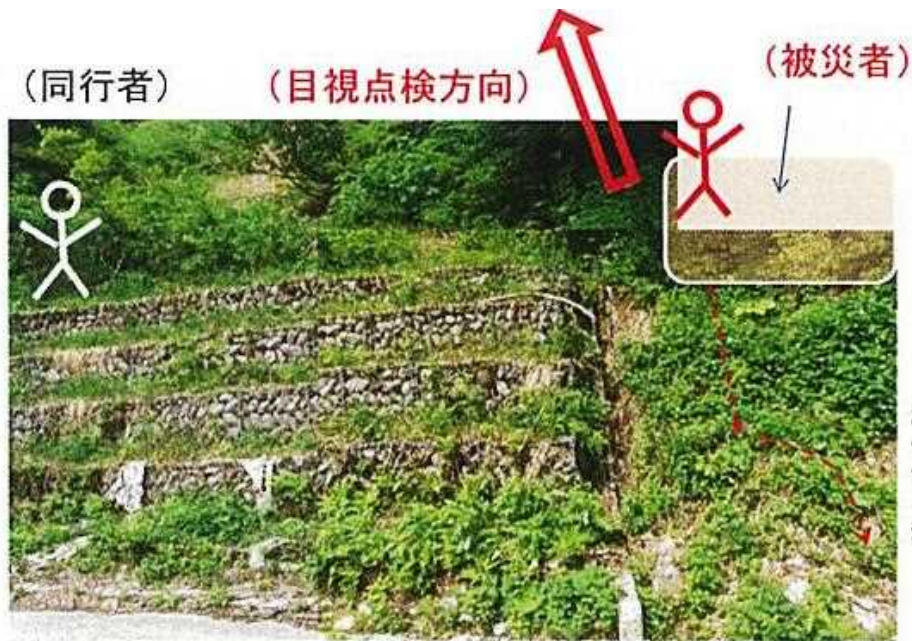
【事故発生箇所(H28撮影)】
