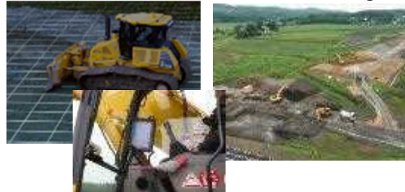
ICT建機での施工
