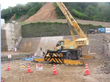
排ガス・低騒音機械確認写真
