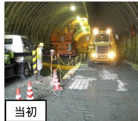
片側施工による大型機械走行状況
