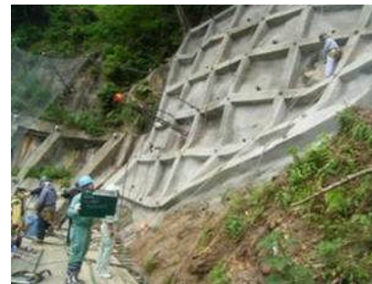
試験施工 削孔状況確認
