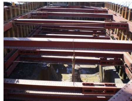
鋼矢板締切全景
