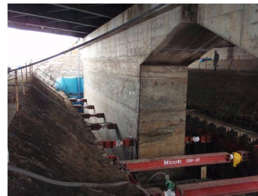
変更後の鋼矢板土留工
