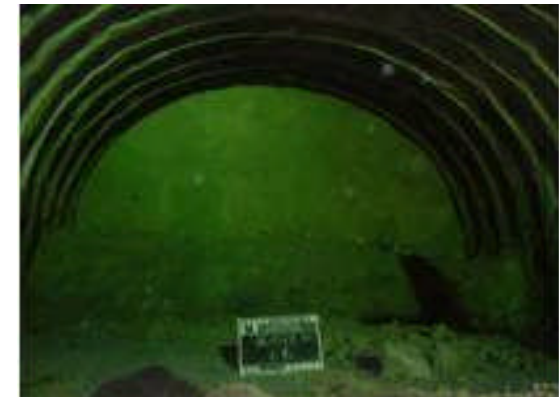
鏡吹付け施工完了状況
