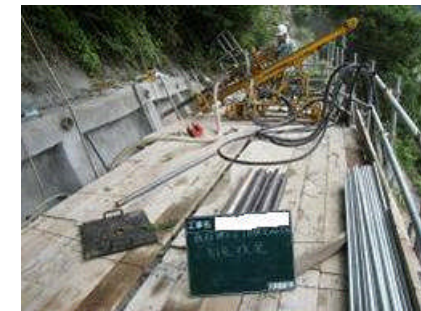
ケーシング併用による削孔
