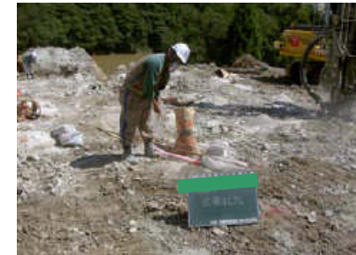
火薬充填状況
