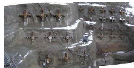
グラウンドアンカー施工状況
