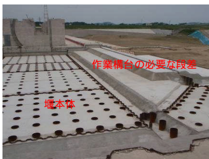
施工ヤード状況
