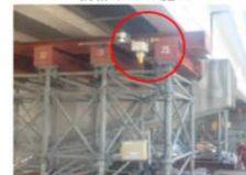
レーザーバリア設置状況
