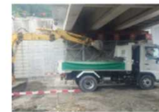
橋桁下での施工
