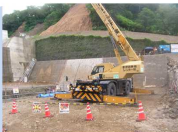
排ガス・低騒音機械確認写真
