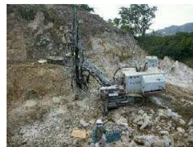
火薬搾孔状況
