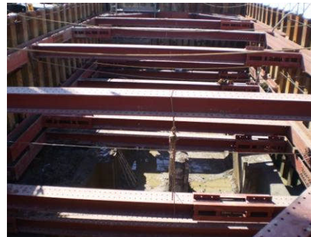
鋼矢板締切全景
