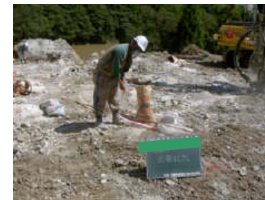
火薬充填状況
