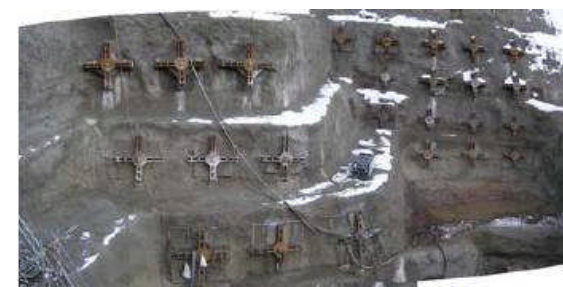
グラウンドアンカー施工状況
