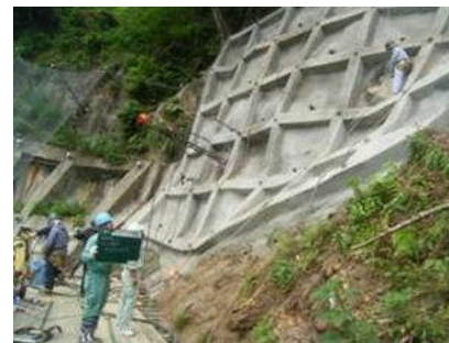
試験施工 削孔状況確認
