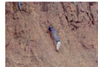
掘削後の切断状況
