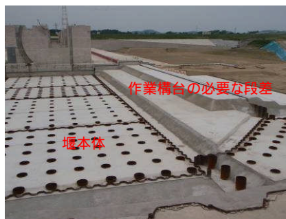
施工ヤード状況
