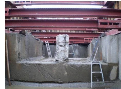
変更対象(切梁下方部)
