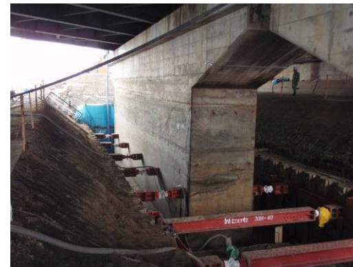
変更後の鋼矢板土留工
