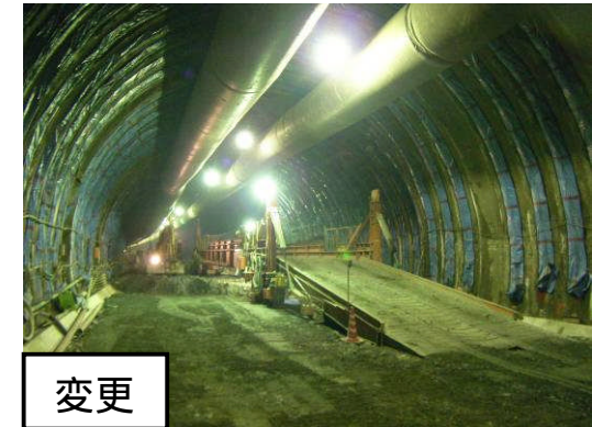
片側施工による大型機械走行状況
