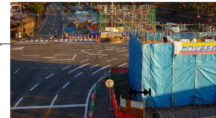
現道と近接している。
