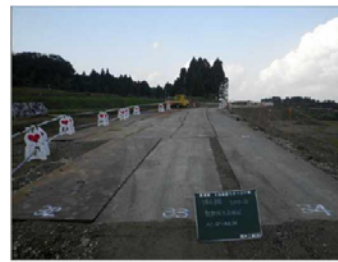
工事用道路 敷鉄板
