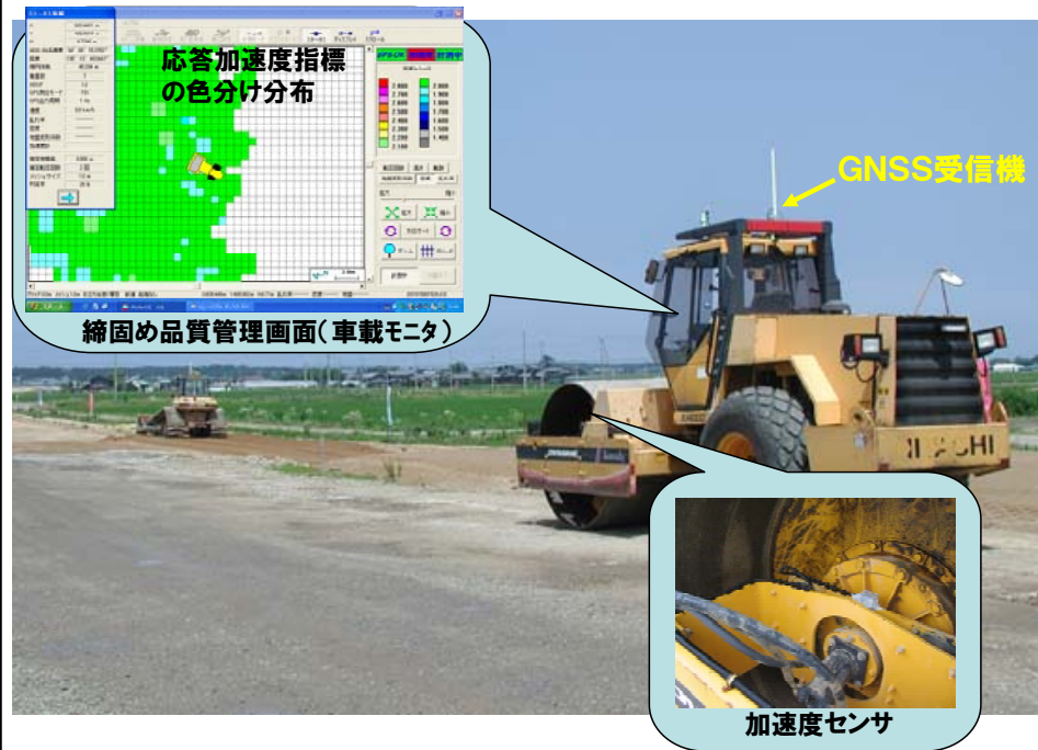
振動ローラの加速度応答による面的な品質管理技術(強度) (例)
