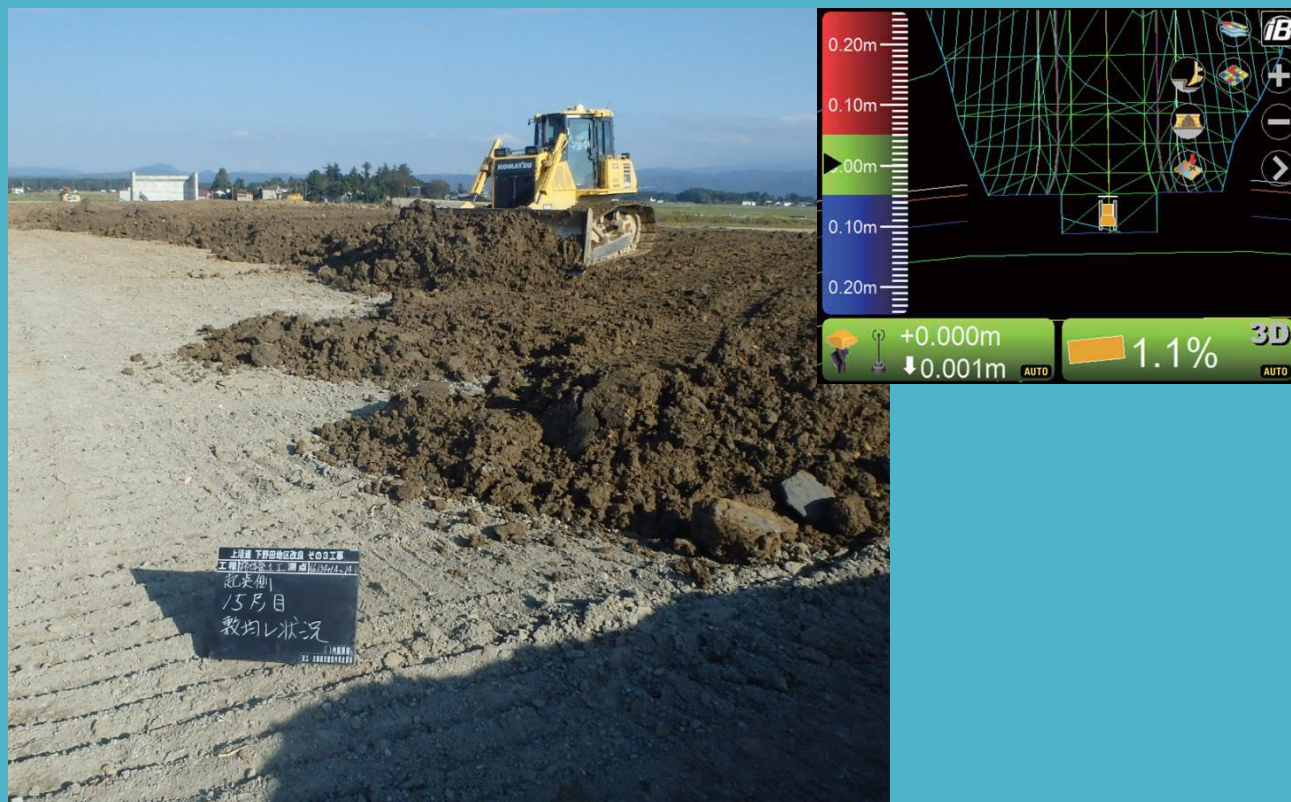
3Dマシンコントロールブルドーザ(21t級) 車載モニター
