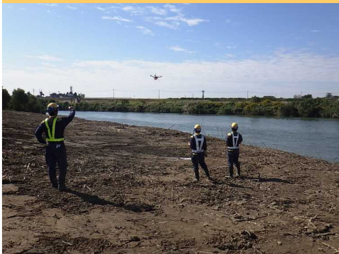
UAV（ドローン）による測量
