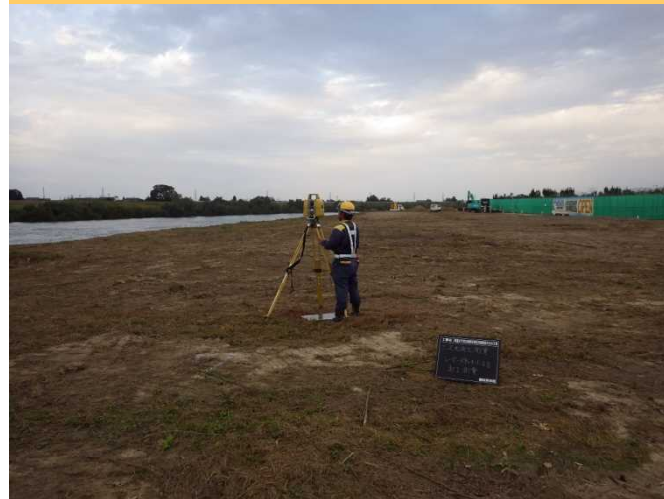
3Dレーザースキャナによる測量
