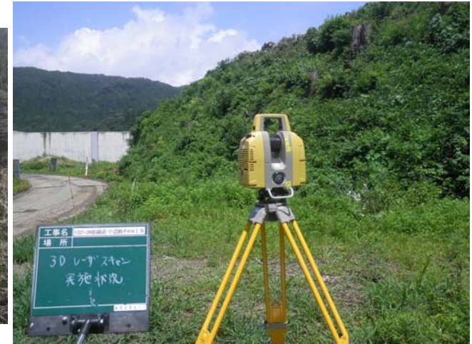
レーザーสキャナーによる起工測量
