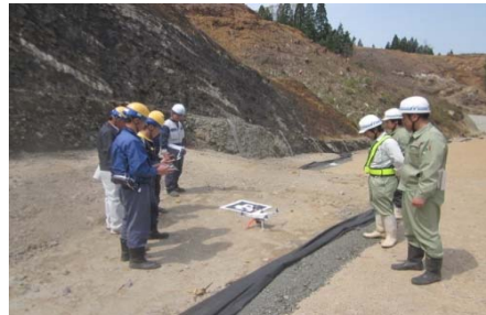
UAV測量による現況データ
