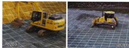
ICT建機の刃先の座標データを自動取得（切土部）
