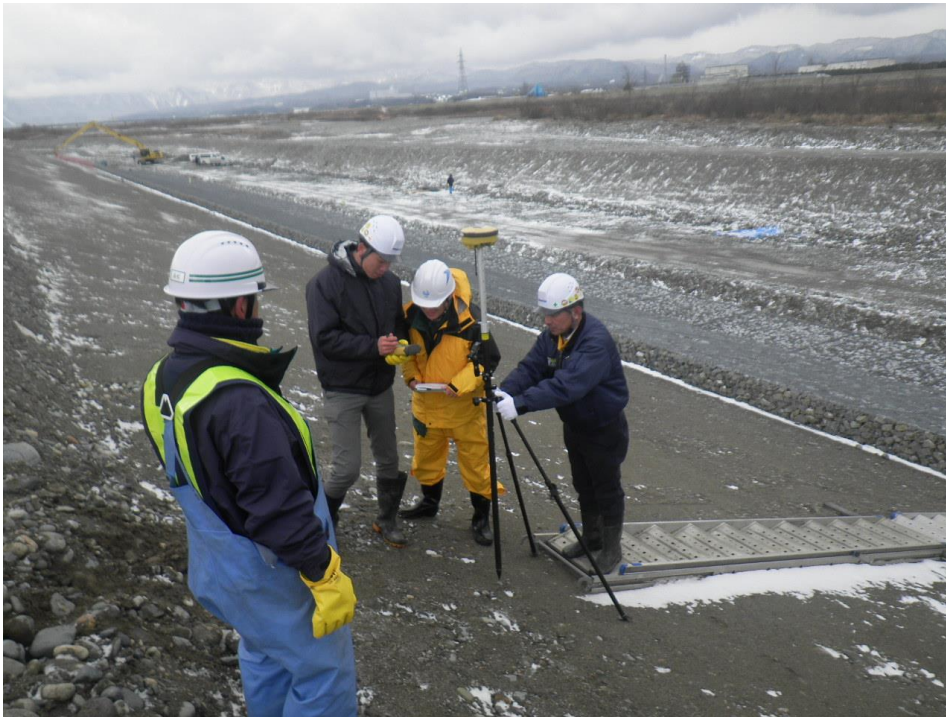
※GNSSローバー 衛星情報の測定器
