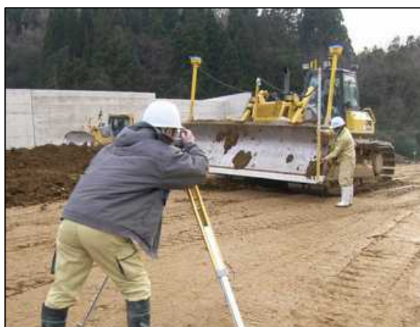
写真 5-1-3 施工前や施工中にブルドーザの排土板の高さを作業前に確認(出典：巻末資料 i))
