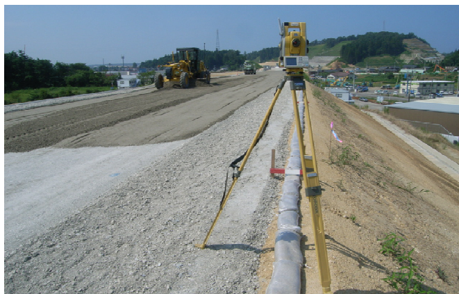
写真 5-1-1 基地局（トータルステーション）の設置事例（出典：巻末資料 i）
