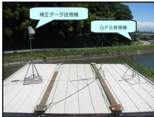
写真 5-1-2 基地局 (GNSS) の設置事例 (出典：巻末資料 i)
