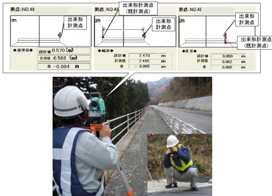
図-4 出来形計測状況
