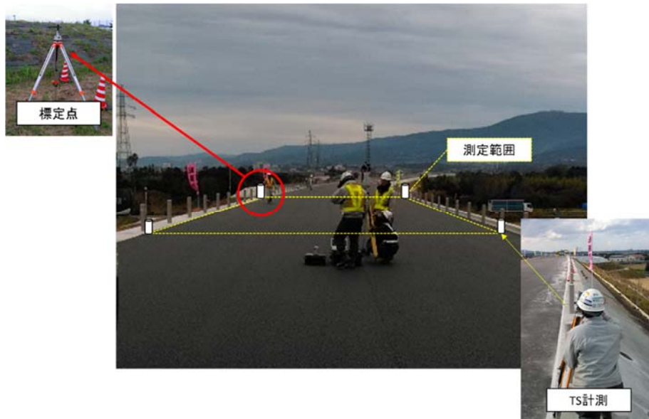
図 1-16 TLSと標定点の配置（例）
