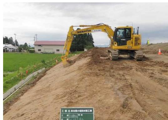
写真-1 ICT建機による法面整形
