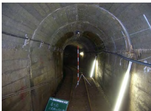
着手前(分岐部)
