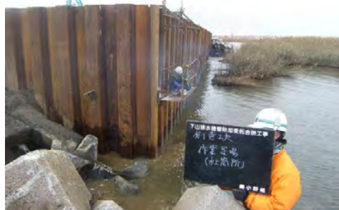
タイロット取付川側吊り足場
