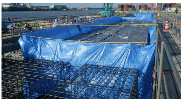
品質向上に向けた舗装施工状況
