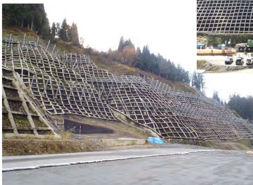
雪崩予防柵工(三角フェンス)
