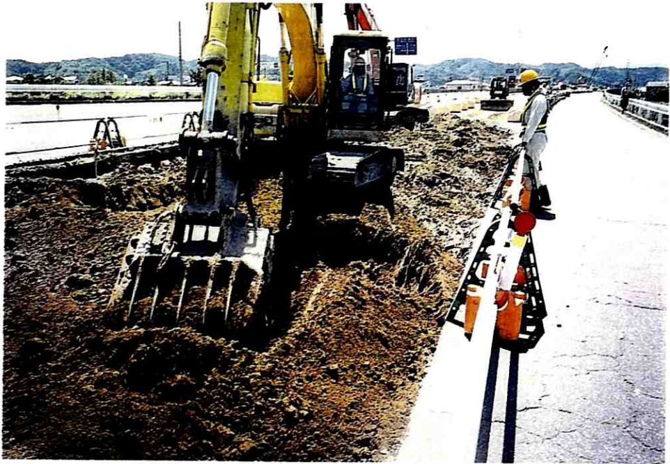
③ 内蔵ロータリーによる混合攪拌状況
