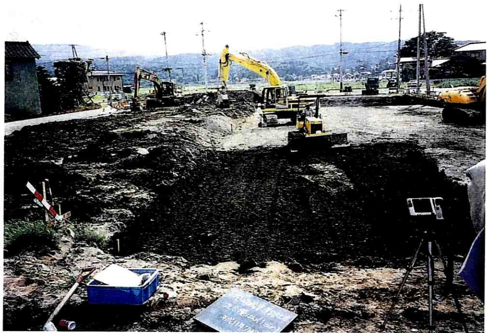
⑥ ブルドーザによる敷き均し状況
