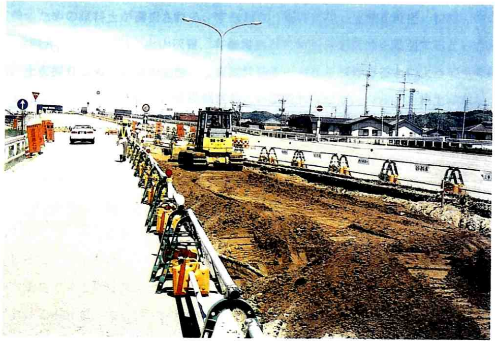
⑤ ブルドーザによる敷き均し状況
