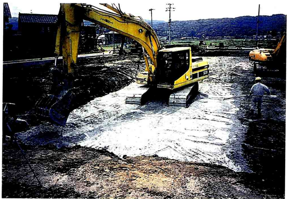
③ 改良材の敷き均し状況
