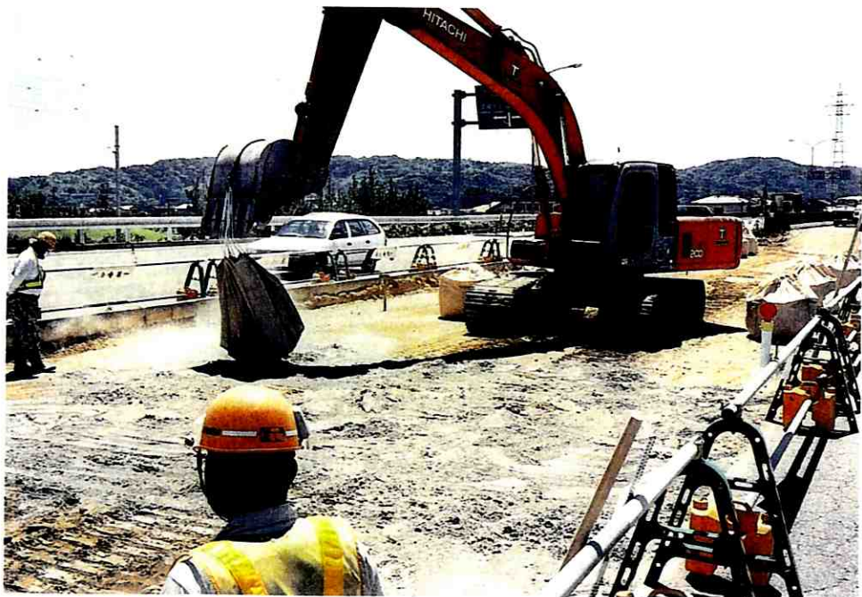
② 改良材の敷き均し状況
