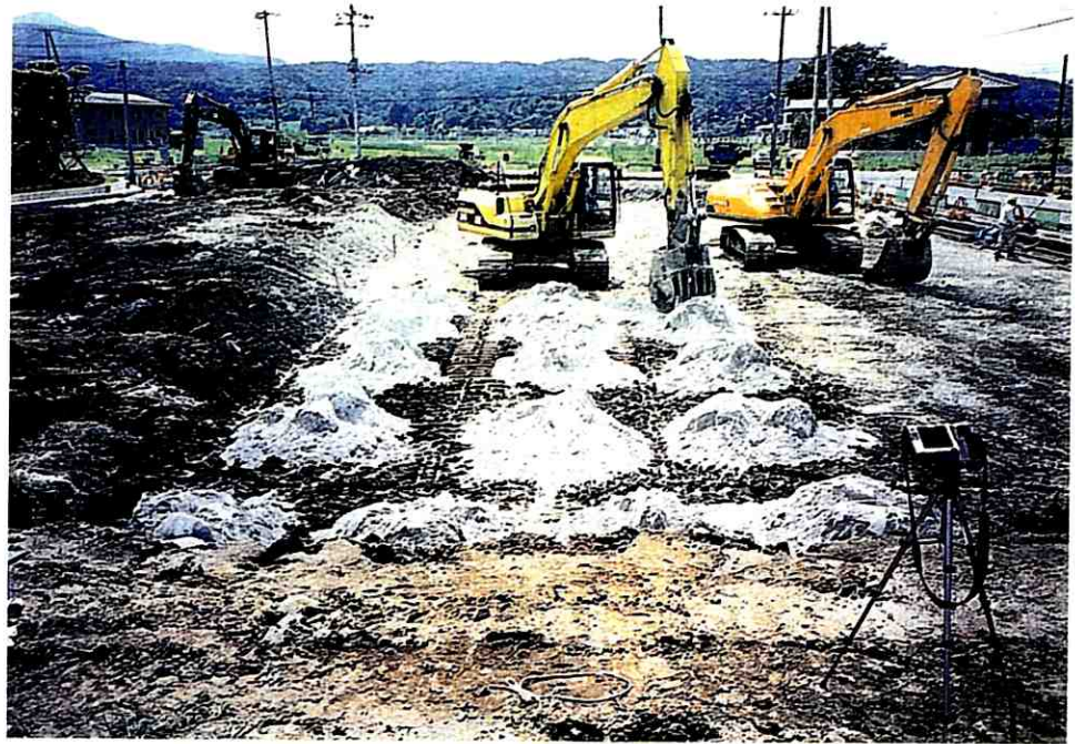
② 改良材の配置状況
