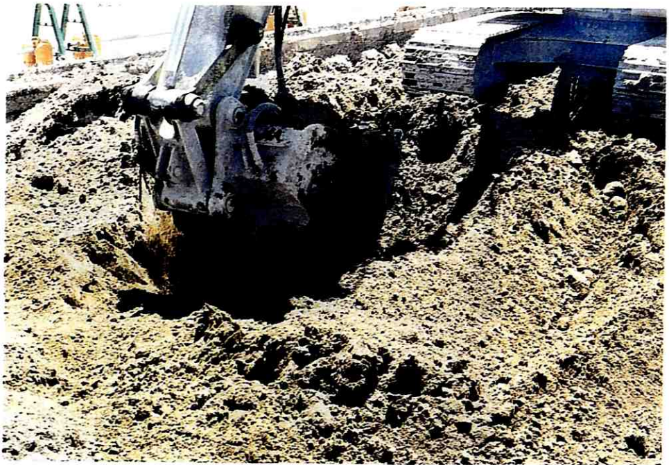
④ 内蔵ロータリーによる混合攪拌・排土状況
