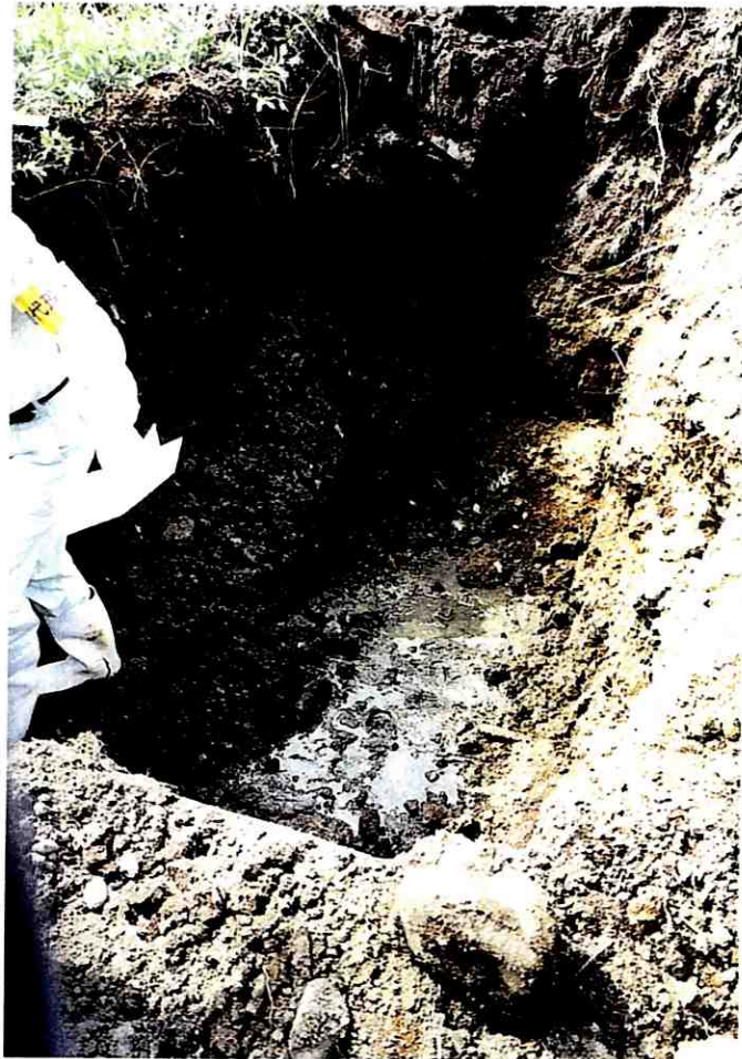
① 改良前の対象土の状況
