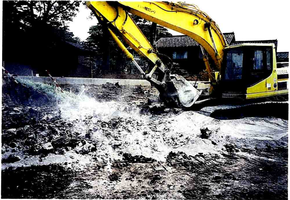
④ 掻き起こしによる対象土と改良材の混合状況
