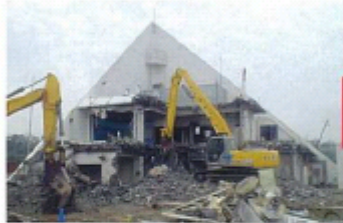
既設建物を解体
