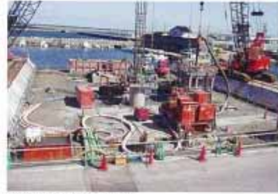
橋脚基礎杭の施工現場
