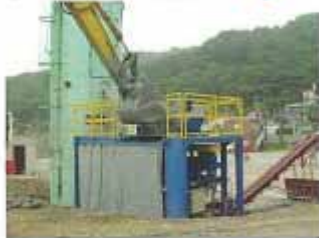
④プラントによる改良
