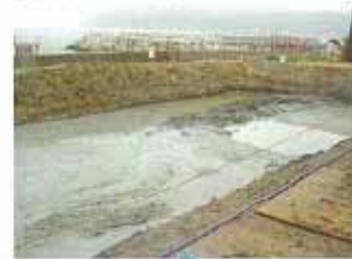
③改良ヤードに仮置
