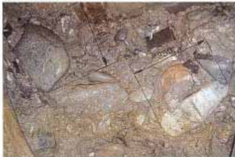
切羽地山状況
