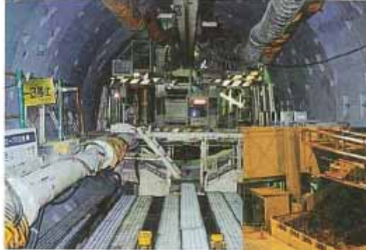
シールドマシン搬送状況
