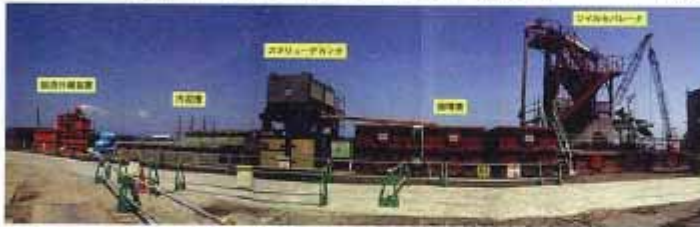
現場全景(最新分級システム)
