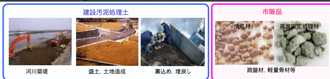
図 2-2 建設汚泥再生品の一例
