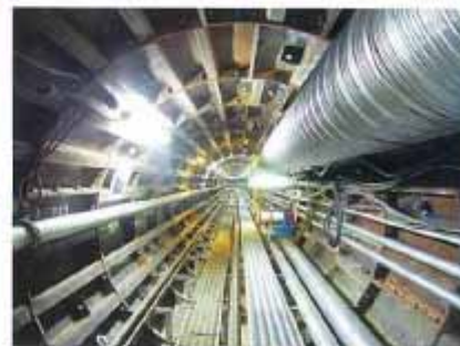
トンネル工事内部
