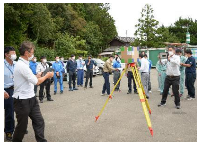
大河津分水路山地部掘削その16工事 (R4.9.27)
