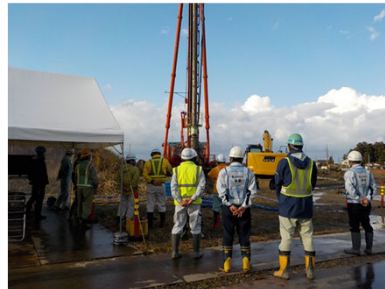
上沼道 岡木地区軟弱地盤改良その7工事 (R4.11.8)
