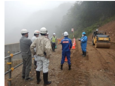
R4湯川第15号砂防堰堤工事 (R4.9.7)
