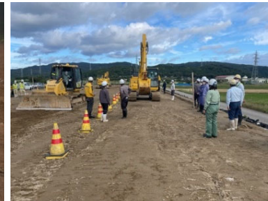
R3羽咋道路 羽咋・本江道路改良工6事 (R4.9.28)
