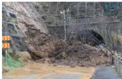
土砂崩壊発生状況
