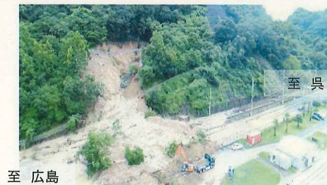
至 広島 至 呉 にほ くれ 広島呉道路(仁保IC~呉IC)の被災状況
