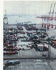
神戸港六甲アイランド RC6/7の被災状況
