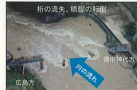
JR西日本芸備線第1三篠川橋りょう
