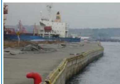
被災事例(岸壁のはらみ出し)
