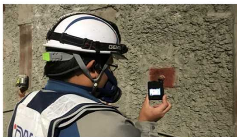
【立会状況 (現場側)】
