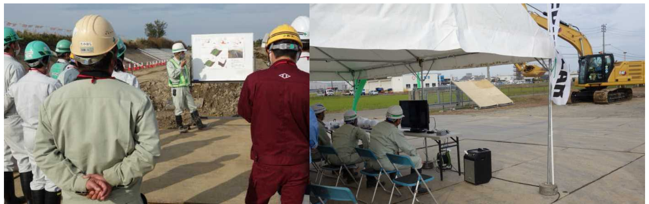
現場見学・ICT建機試乗会
