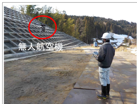
無人航空機（ドローン）による 3次元測量
