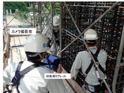
①臨場(受注者)の状況
