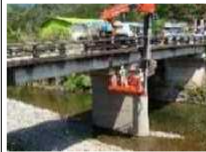
インフラの維持管理(点検作業)
