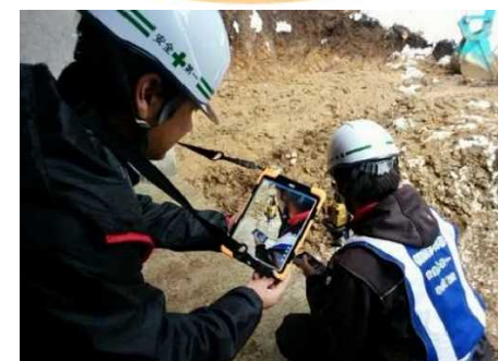
現場の状況を映像データ等により事務所に報告
