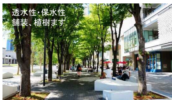
雨水貯留・浸透等の機能を持つ歩行空間
