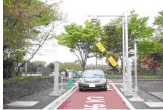
SA・PA等に接続し、地方公共団体が主体となって整備するETC専用のスマートインターチェンジ
