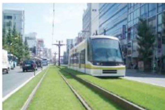
既設の路面電車の軌道敷を芝生化
