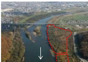
・河道掘削や樹木伐採
