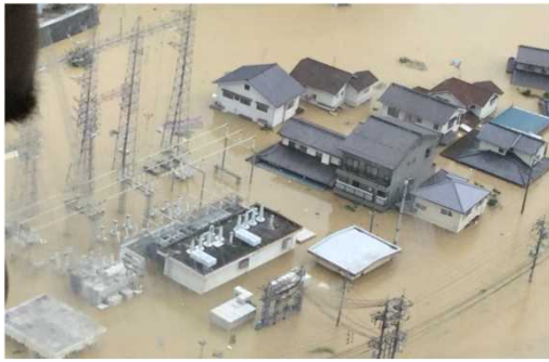
河川の氾濫により水没した沼田西変電所 (広島県三原市)
