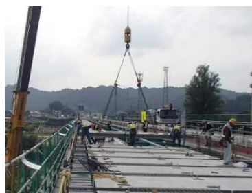
プレキャスト床版による 打ち替え
