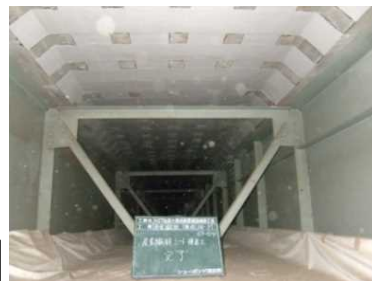
炭素繊維シートの貼り付け
