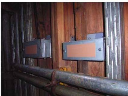
ボス型枠の取付け状況
