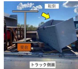
事故状況写真
