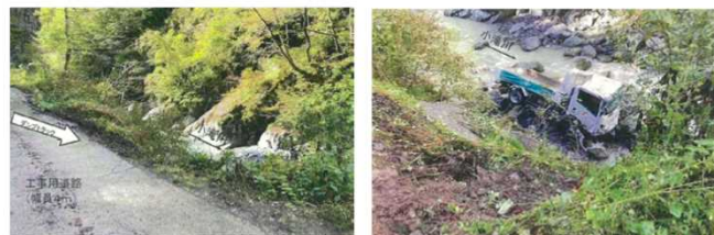
事故発生時の状況写真
