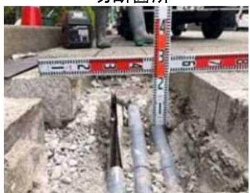
切断した埋設管
