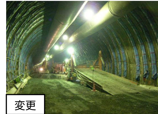
片側施工による大型機械走行状況
