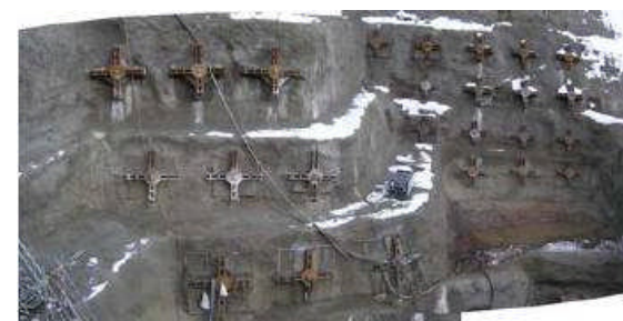
グラウンドアンカー施工状況
