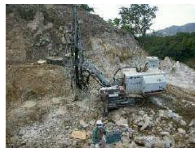
火薬搾孔状況
