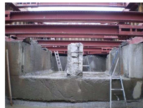
変更対象 (切梁下方部)
