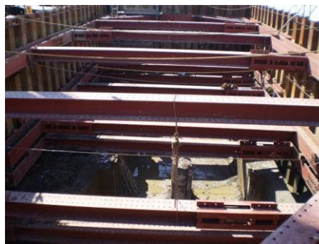
鋼矢板締切全景
