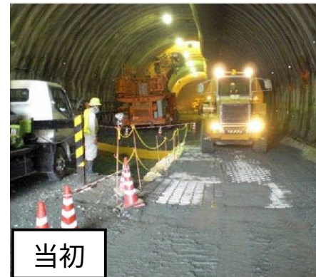
片側施工による大型機械走行状況
