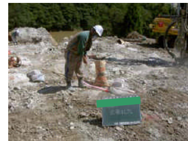
火薬充填状況
