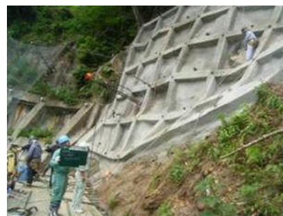
試験施工 削孔状況確認
