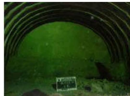
鏡吹付け施工完了状況
