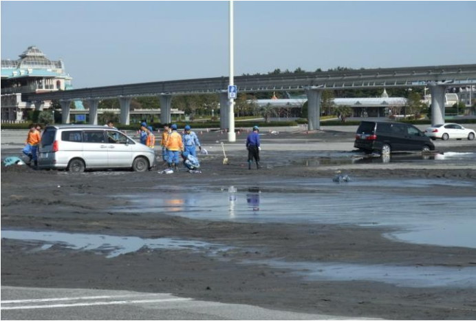
東北地方太平洋沖地震による液状化現象(浦安市ディズニールランド駐車場)写真提供: 東京電機大学安田教授
