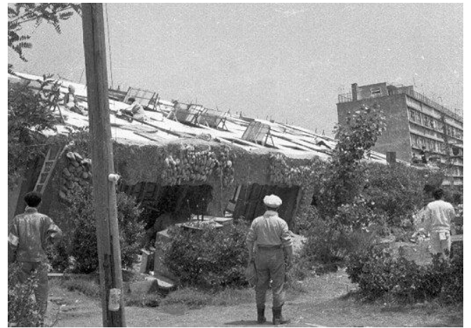
新潟地震による液状化で倒壊した県営アパート(新潟市川岸町)写真提供: 渡邊馨一郎氏
