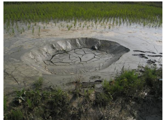
液状化による噴砂の例
