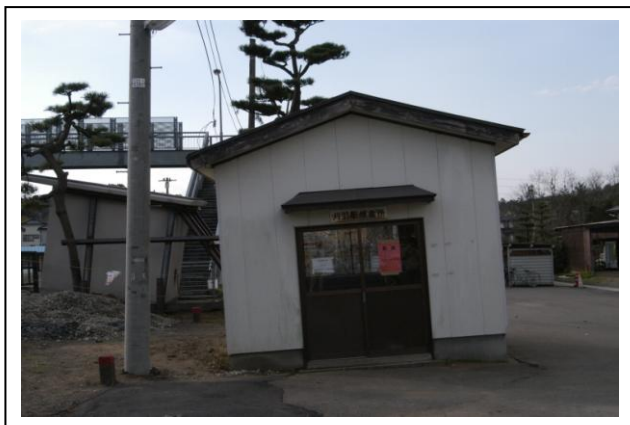
①建物の沈下・転倒
