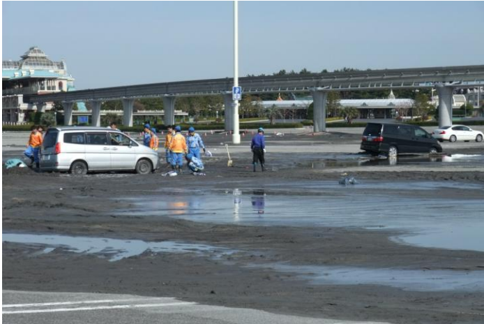
東北地方太平洋沖地震による液状化現象(浦安市ディズニーランド駐車場)写真提供:東京電機大学安田教授
