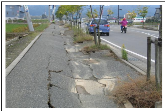
③歩道部の地盤沈下
