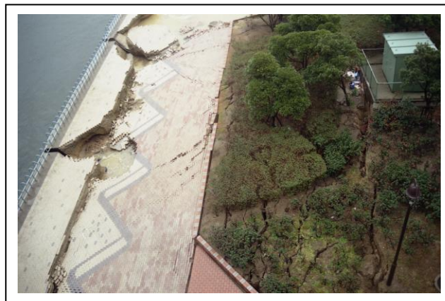
④側方流動による護岸の変状
