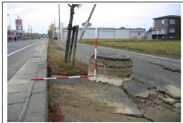
②マンホールの浮き上がり
