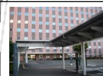
駐車場 雨除けの庇
