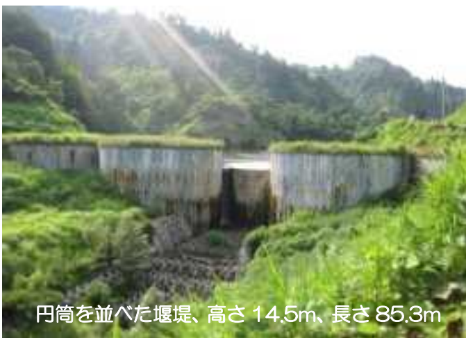
完成間近の十二平下流砂防堰堤
