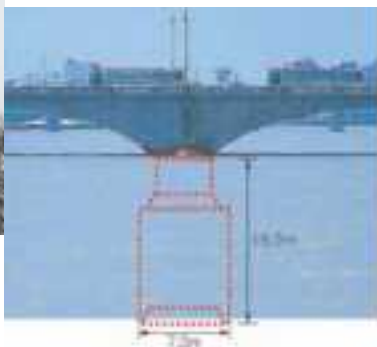
ニューマチックケーソン工法 地上設備と土台部分
