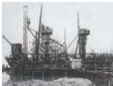
ニューマチックケーソン工法 地上設備と土台部分
