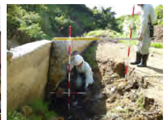
被災状況調査
