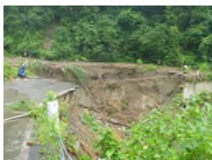
被災状況調査 (社)建設コンサルタント協会北陸支部提供
