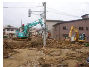
応急復旧作業
