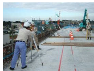
写真-3 ③床版の出来形管理
