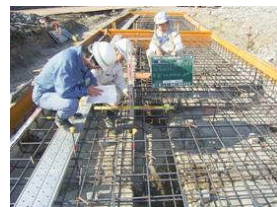
写真-1 ①鉄筋構造物の配筋状況の確認
