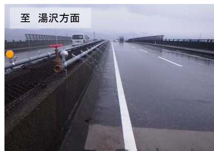
新組跨線橋（上り）
