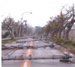
台風で電柱が倒れ通行止め
